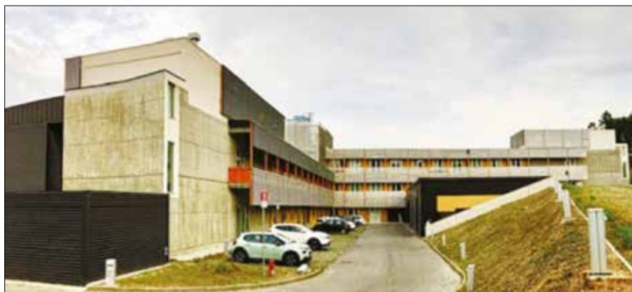
Figura 1 – Esterno del laboratorio.
